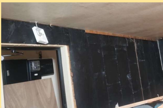
壁に遮音マットを張り付けています
