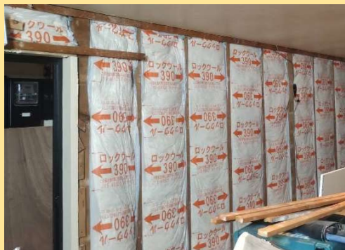
壁の中に吸音材を充填しています
