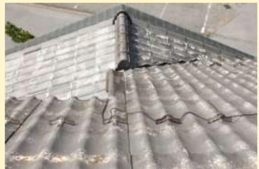
軽量瓦の表面が剥離し、基盤が水分を含み亀裂を起こしています。
