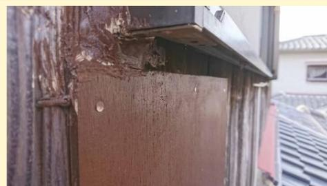
劣化が激しい部分の焼板は張り替え、その他の焼板は塗装します。
