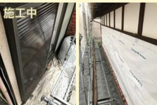
こちらは雨戸の塗装と劣化した焼板の張替です。焼板は一旦撤去して、防水・透湿シートを施工します。それから焼板を張っていきます。
