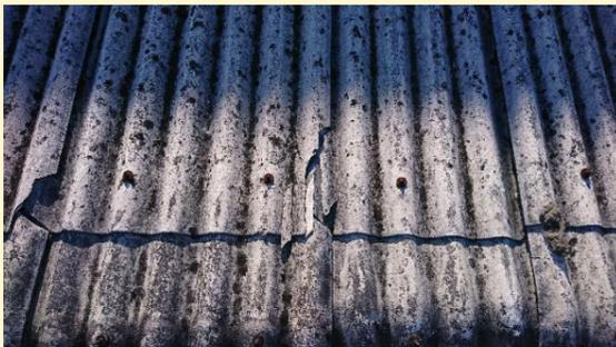
スレート屋根材の表面劣化や割れ、コケの発生、ボルトのサビが目立ちます。
