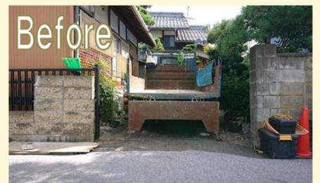
ガレージ入口の両サイドのブロック塀が傾き等で劣化していました。鉄製ゲートの作動も困難でした。
