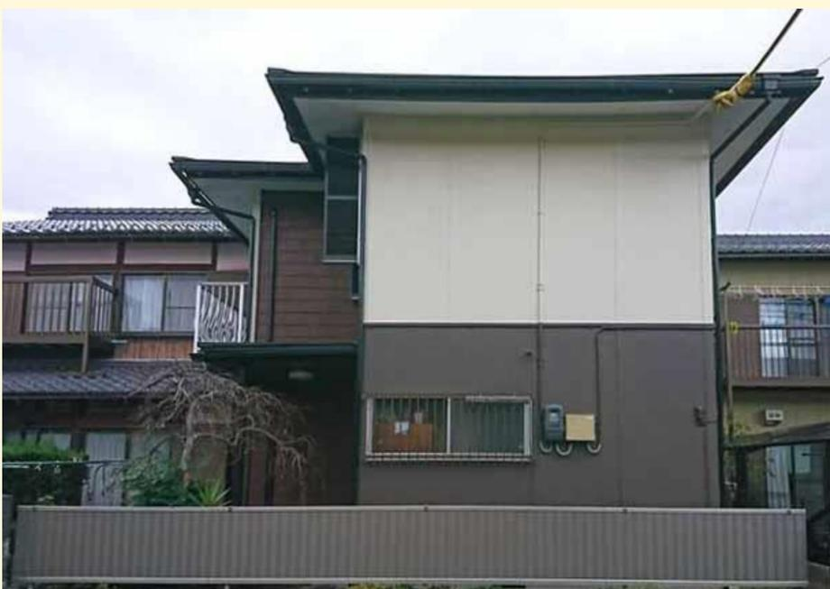
軒の雨樋は新調し、電気の引込位置も屋根からの落雪を受けにくい端の方に移設しました！
