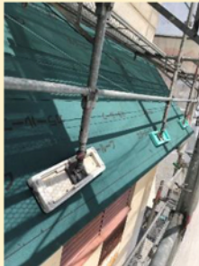
ルーフィング施工
