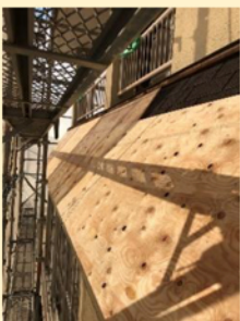
屋根下地施工
