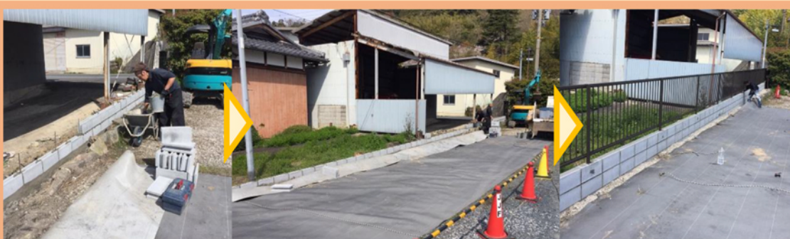
ブロック施工
