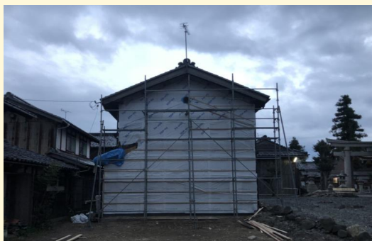
建屋の解体が終わると、母屋との取り合い部の壁を仕上げていきます。
