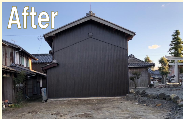
外部足場を撤去し、完成です。
