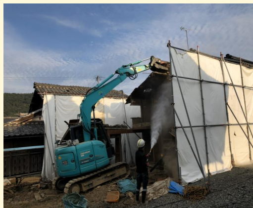
埃が飛散しないように、散水しながら作業を進めます。
