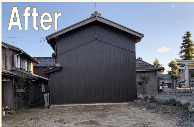
外部足場を撤去し、完成です。
