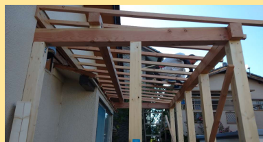
増築部の建方中
