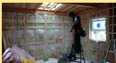
明るさをイメージしながらの配線工事
