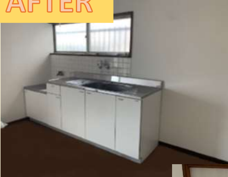
キッチンも設置し綺麗に仕上がりました
