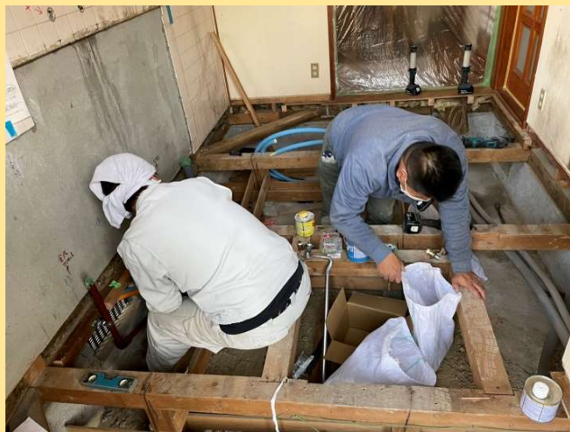
床を解体し、新しい配管を仕込んでいます。
